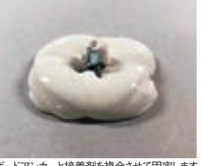
ボードアンカーと接着剤を複合させて固定します
